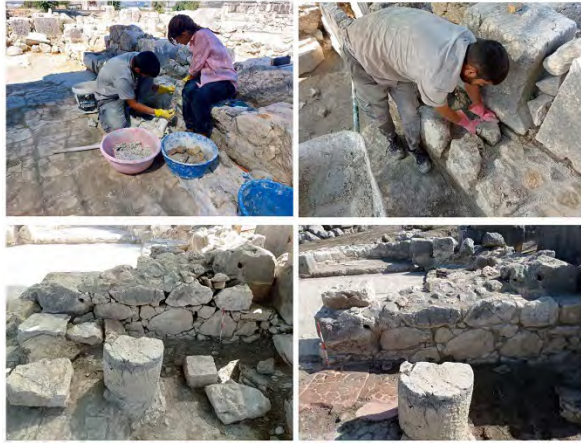
Şekil 10: Kilise Duvarlarındaki Koruma ve Onarım Çalışması
